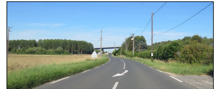
Fig. 99 : Aux alentours de Langeais, l'autoroute qui traverse le fleuve en impose par sa structure de grande envergure.
