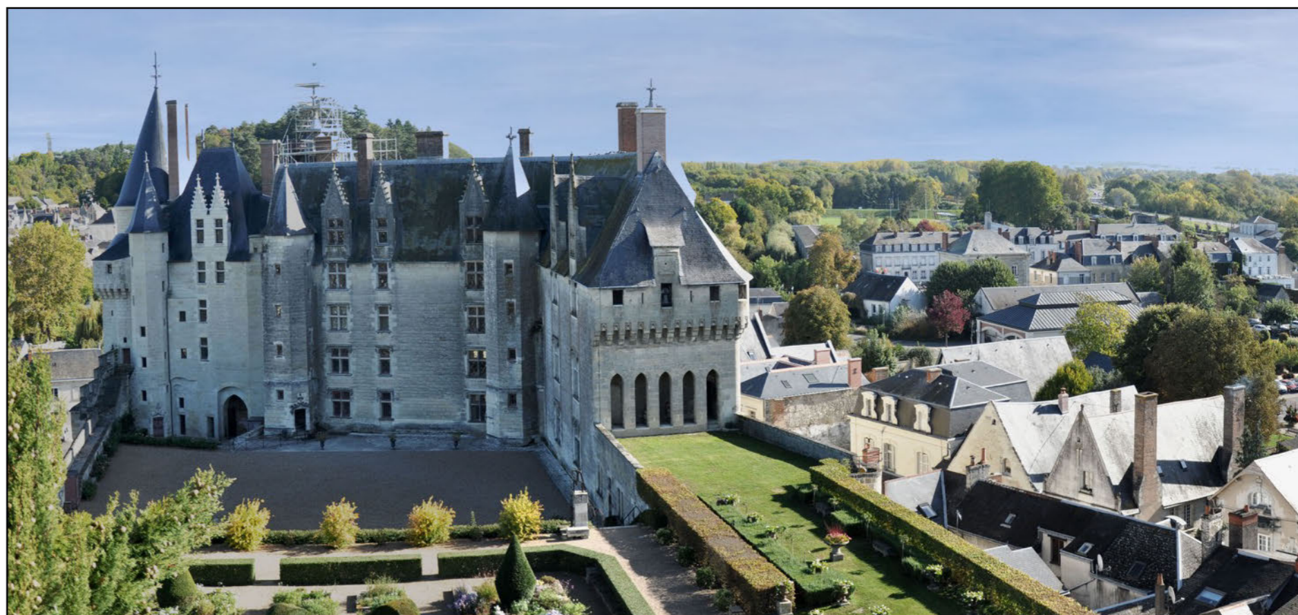
Fig. 103 : Point de vue ouvert sur le château de Langeais et le territoire plus lointain qui l'entoure.
