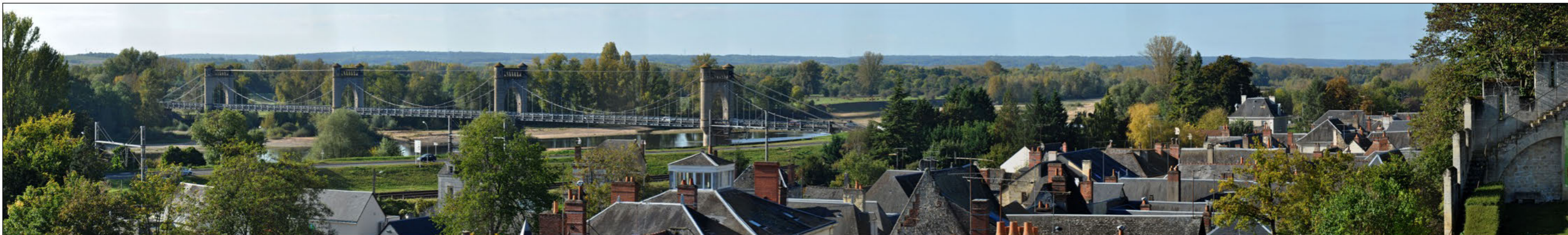
Fig. 127 : Pont de Langeais sur la Loire depuis les jardins du château
