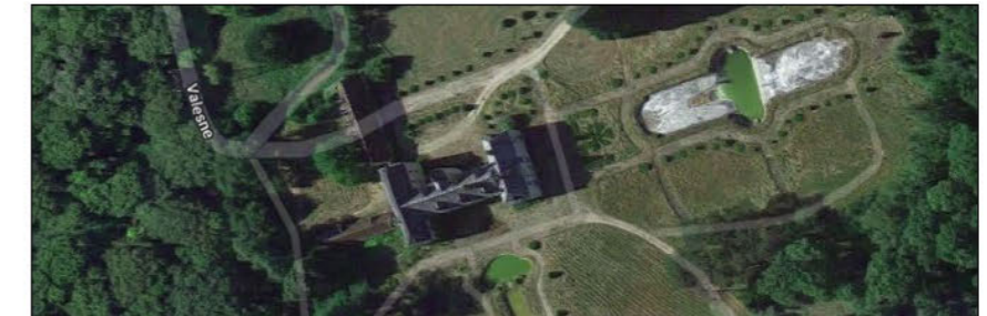
Fig. 72 : Château de Valesne à Saché
