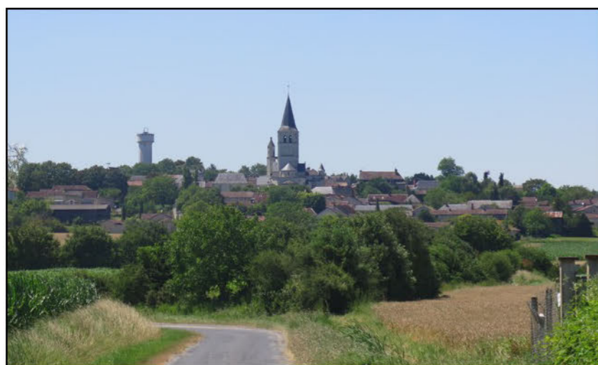
Fig. 116 : Le village de Faye-la-Vineuse domine le plateau. Sur ce point de vue, le château d'eau vient concurrencer visuellement la silhouette du clocher en apportant un second élément vertical au sein du panorama.
