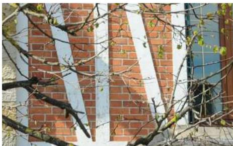
NOTA : Entre-deux-guerres, une fausse charpente est souvent rapportée sur la maçonnerie pour évoquer le pan de bois, sans charpente ; exemple d'une fausse charpente en enduit sur un mur de briques industrielles apparentes.
