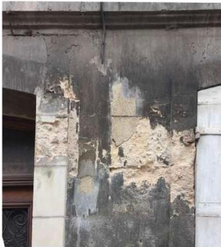
Exemple d'un enduit sur pierre appareillée inadapté (au ciment) = la pierre se désagrège sous l'effet de l'humidité emprisonnée.
